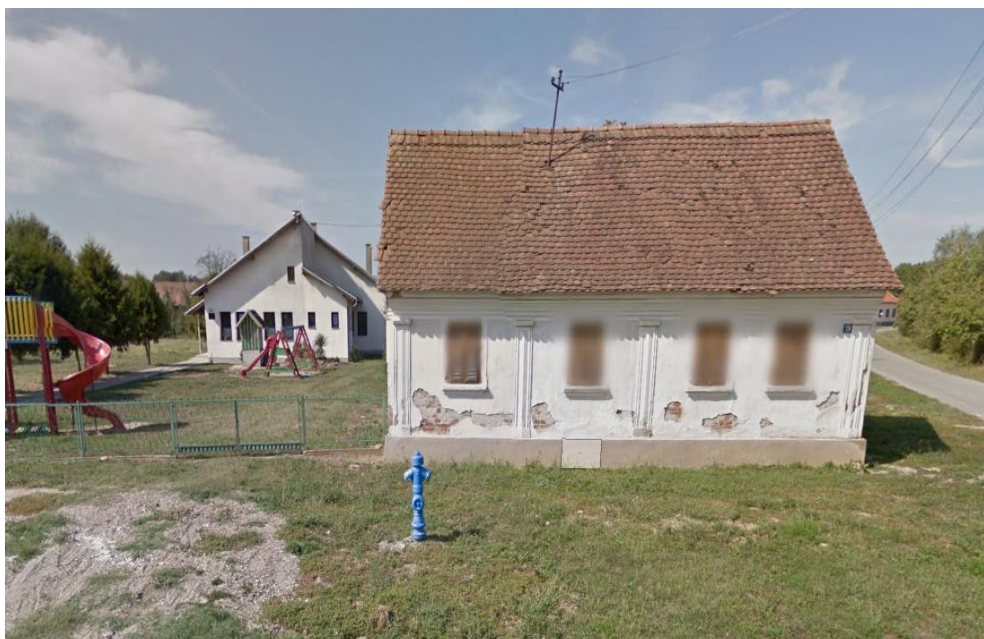
SLIKA 8: NADZEMNI HIDRANT U NASELJU SIČE
